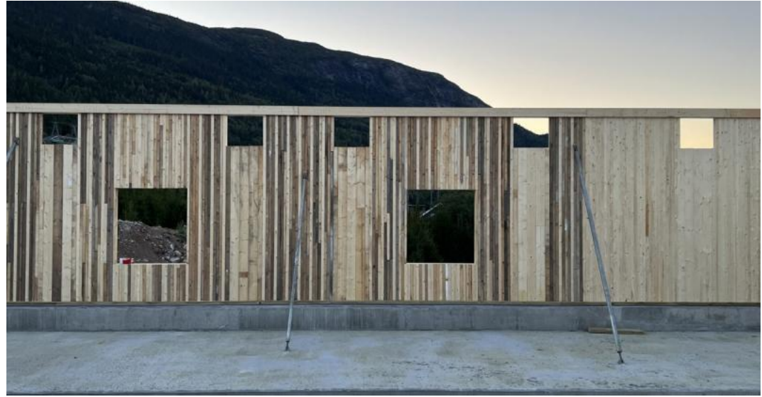
Foto: Norsk Massivtre
