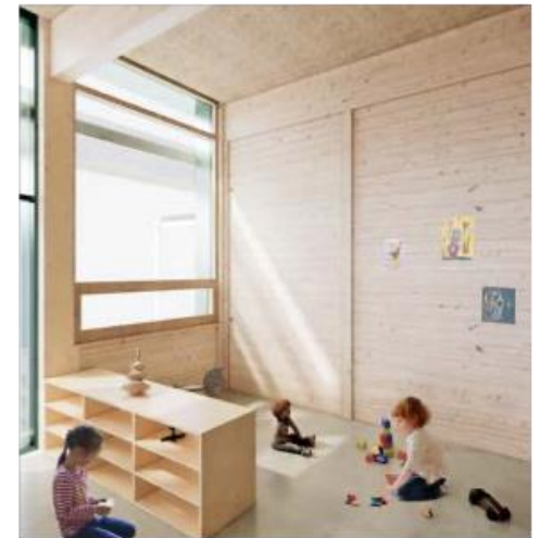
Konstruksjonsvirke kan bli innvendig kledning
